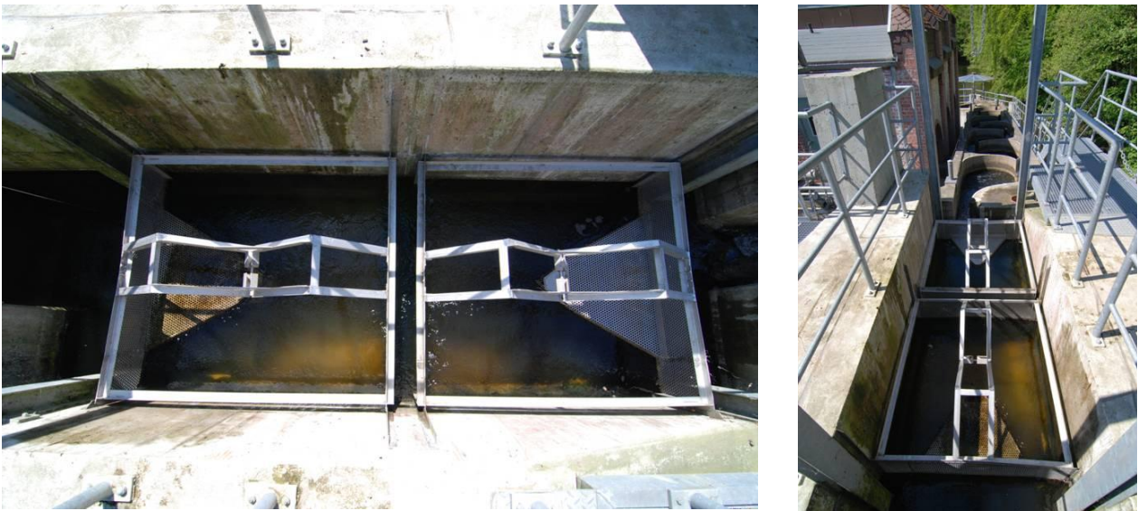
Abbildung 1: Fangreusen in der Funktionskontrolle am WKW Raisdorf 2
