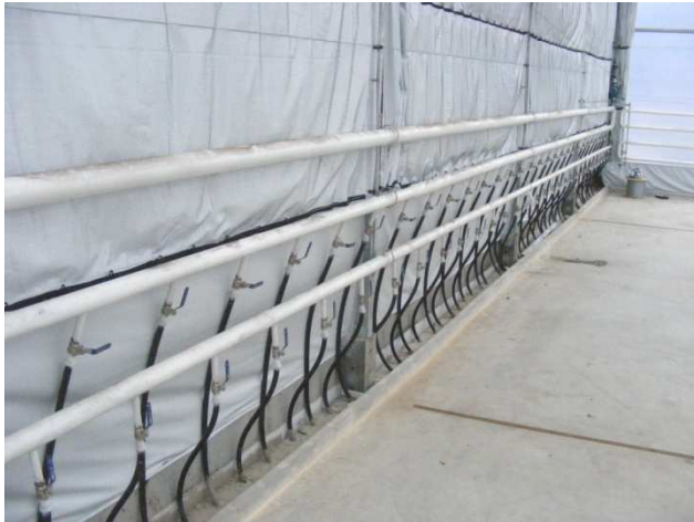
Abb. 8: Bodenheizung nach dem Tichelmannprinzip
