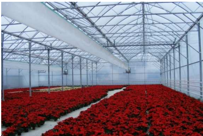
Abb. 10: Wärmeverteilung über die Polyethylenschläuche
