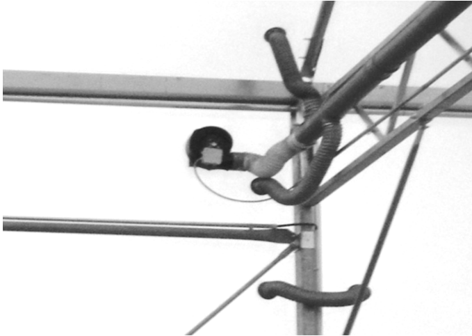
Abb. 5: Vorrichtung zum Aufblasen der Doppelfolie
