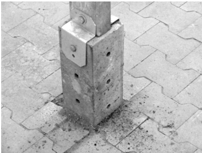
Abb. 4: Betonsockel als Fundament für die Stahlträger
