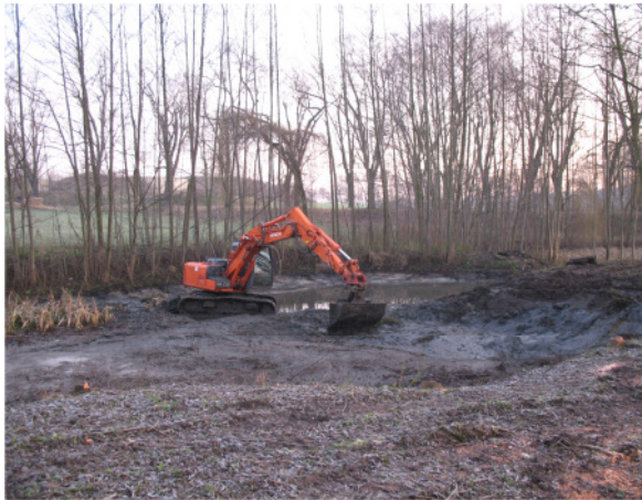
Abbildung 5: Entschlammung und Einbau von Faschinen in der Retentionsanlage II
