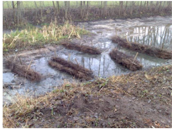
Abbildung 5: Entschlammung und Einbau von Faschinen in der Retentionsanlage II
