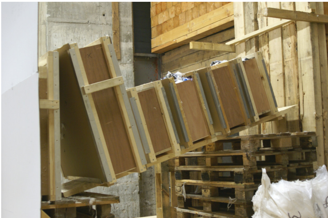
Die Geschossfangkästen sind in Abgangsrichtung der Geschosse positioniert.
