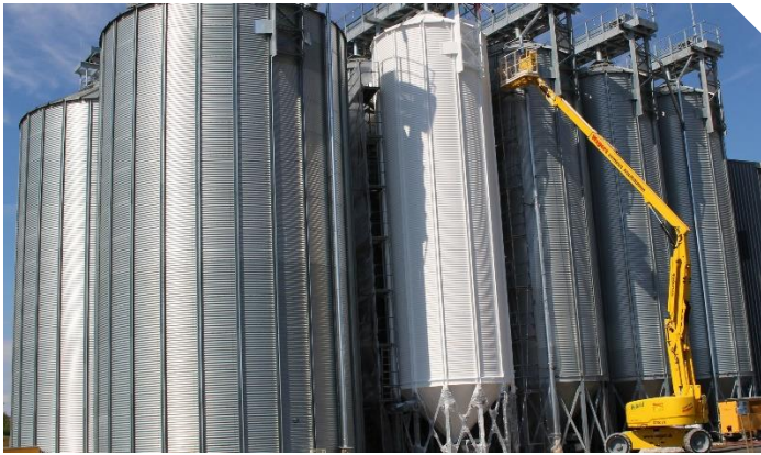
Abb. 1: Ein Silo eines Demobetriebes bekommt einen gasdichten Anstrich.
