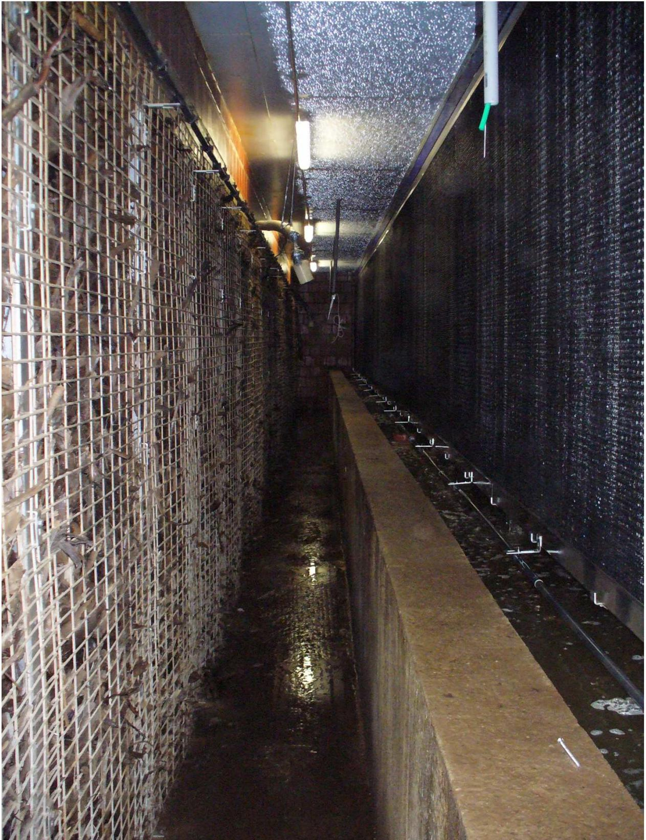
Abbildung 25. Blick in der Zwischenraum der Filterwand 2 (im Bild rechts) und der Biofilterwand (im Bild links) (02.03.2010)
