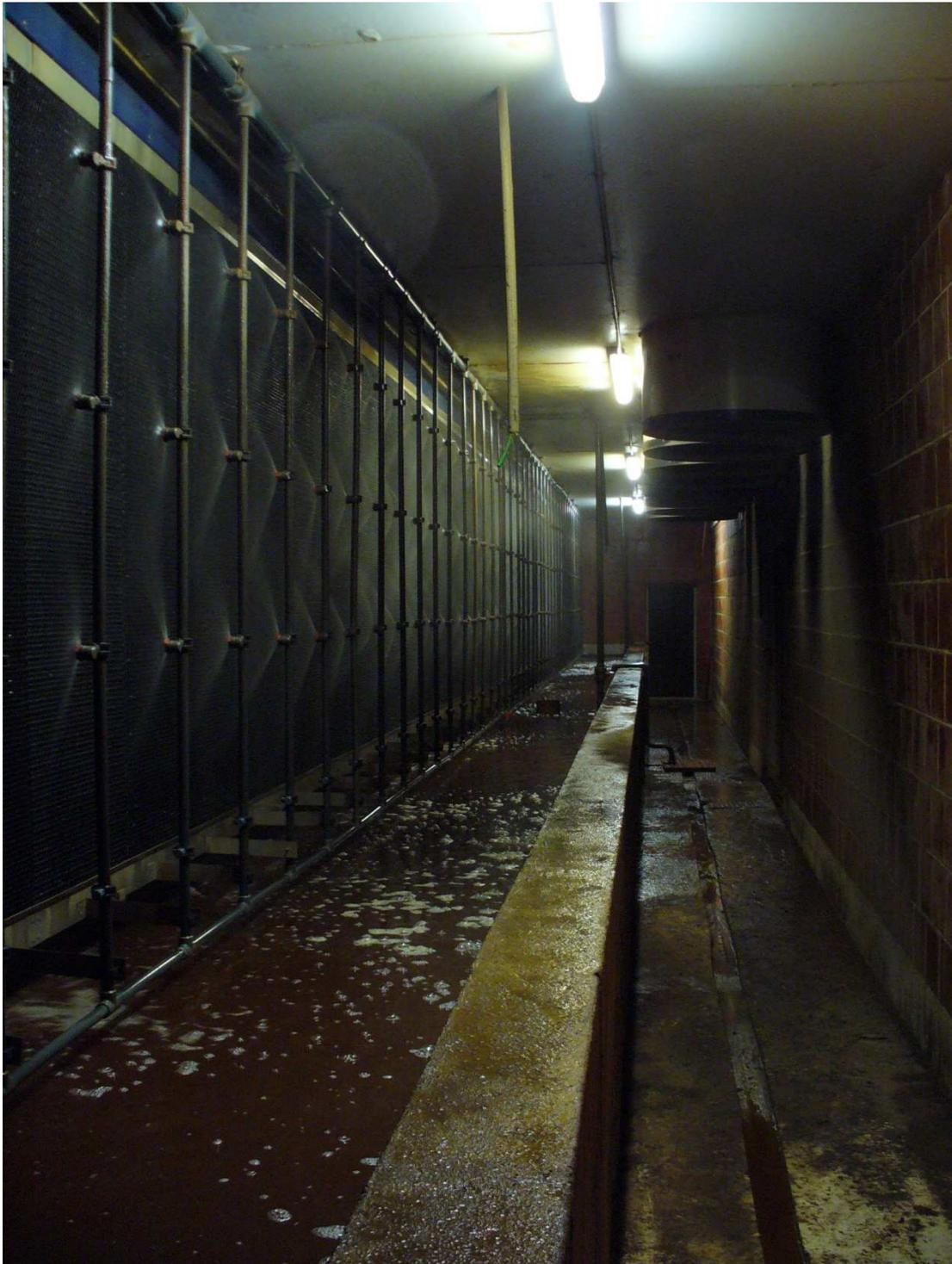
Abbildung 19. Blick auf die Filterwand 1 mit laufender Vorbedüsung (02.03.2010)
