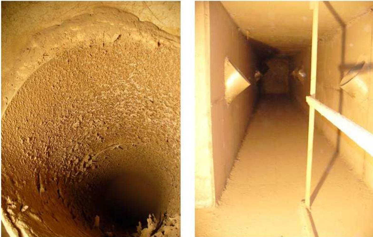
Abbildung 46. Staubablagerungen in einer Abteilabsaugung (links) sowie im Sammelkanal (rechts)
