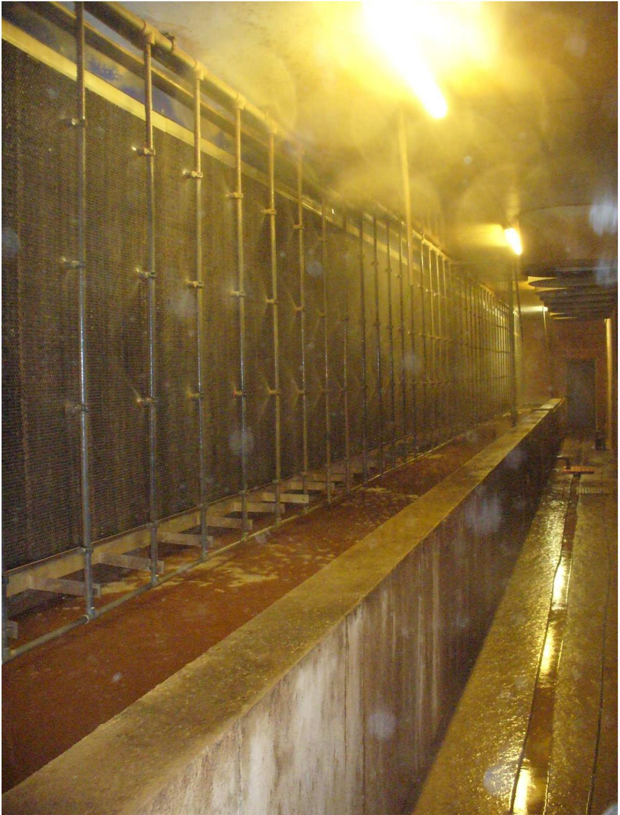
Abbildung 21. Blick auf die Filterwand 1 mit laufender Vorbedüsung (24.08.2010)
