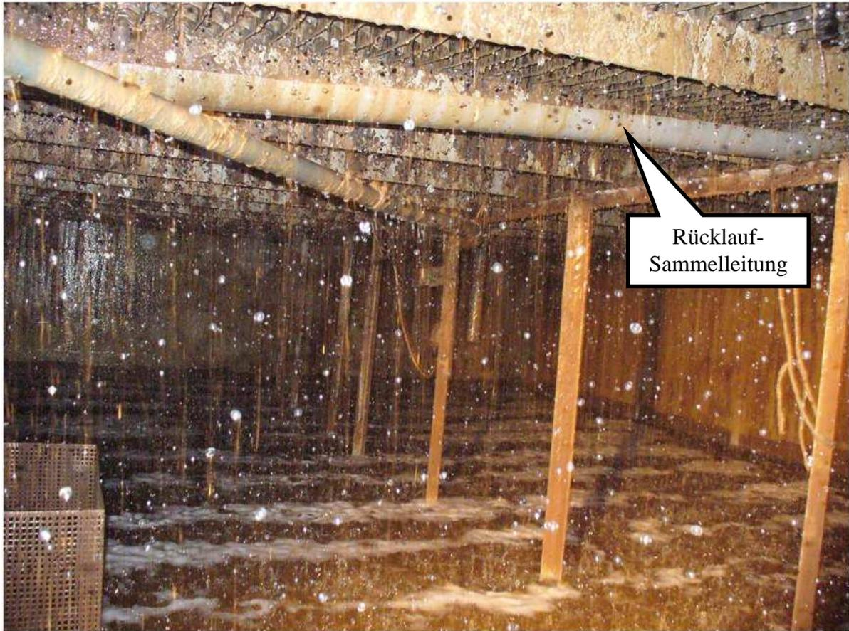
Abbildung 49. Blick auf die Unterseite der Füllkörperpackung mit der Rücklauf-Sammelleitung
