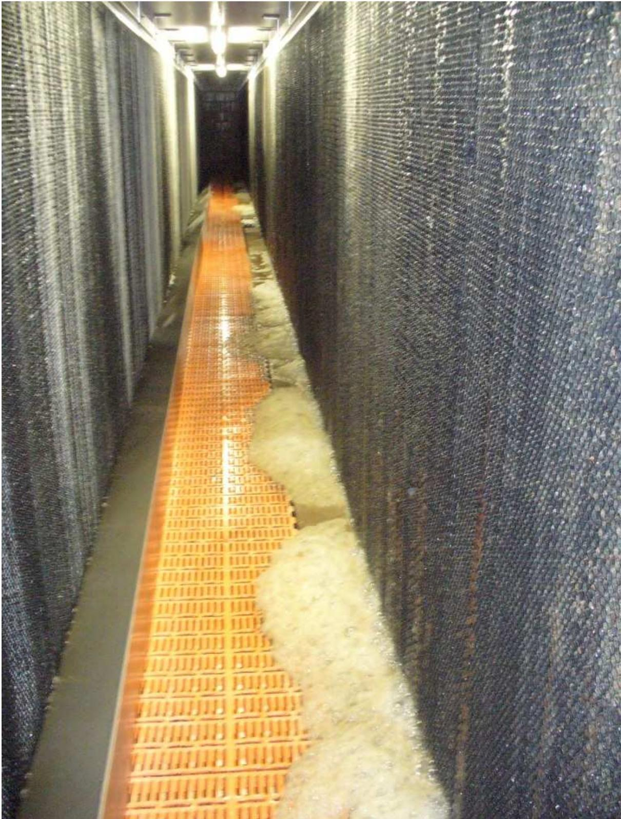
Abbildung 23. Blick in den Zwischenraum der Filterwand 1 (im Bild rechts) mit leichter Schaumbildung und der Filterwand 2 (im Bild links) (25.05.2010)
