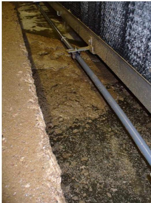
Abbildung 30. Blick auf Frostschäden an den Ziegelwänden (16.03.2010) sowie auf die Waschstufe 2 mit erkennbarer Betonkorrosion (24.08.2010)
