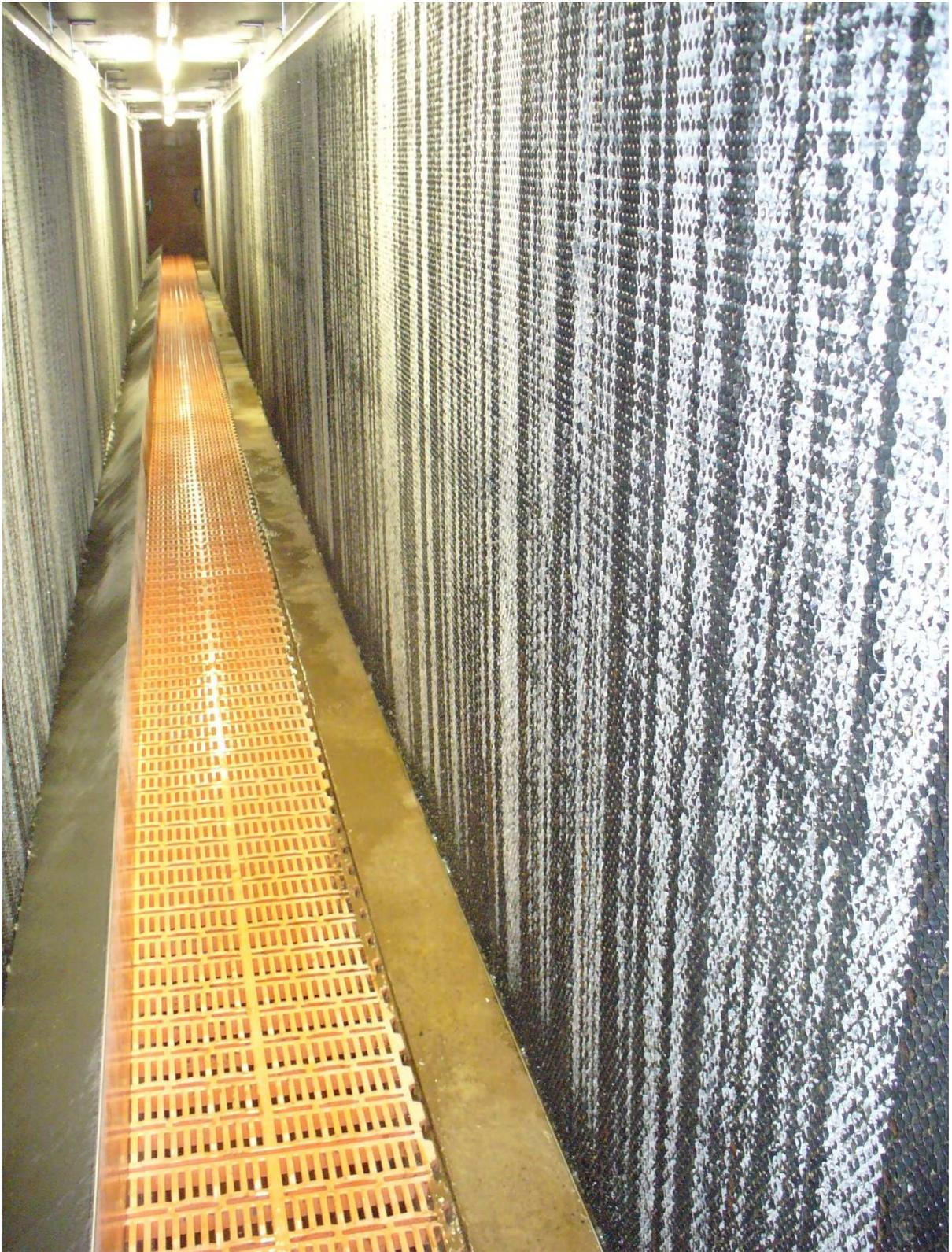
Abbildung 24. Blick in den Zwischenraum der Filterwand 1 (im Bild rechts) mit leichter Schaumbildung und der Filterwand 2 (im Bild links) (24.08.2010)
