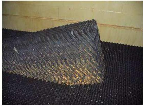
Abbildung 50. Blick auf die Oberseite der Füllkörperpackung mit Wasserverteilsystem (links) und einem schräg gestellten Füllkörperpaket mit ausgebildetem Biofilm (rechts)
