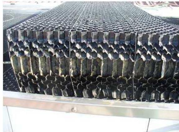
Abbildung 51. Blick auf die Unterseite des Tropfenabscheiders (links) sowie auf die Seite und Oberseite eines ausgebauten Tropfenabscheider-Elementes (rechts)
