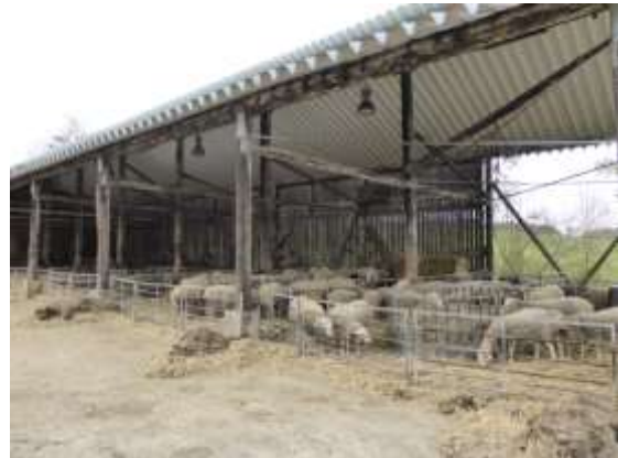
Abbildung 36: Offenfront mit Rundholz und Stahlblechdach
