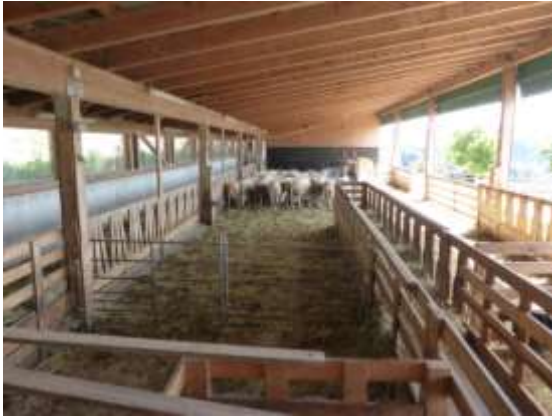
Abbildung 35: Offenfrontstall in Ständerbauweise
