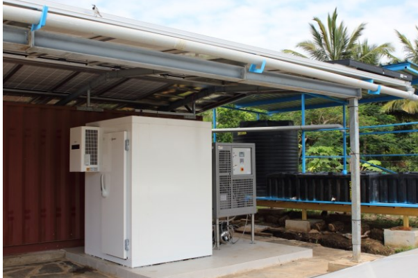
Abb. 5: Eislagerraum und dahinter angeordnete Eismaschine (links), Eishändler beim Abholen des Eises (rechts)
