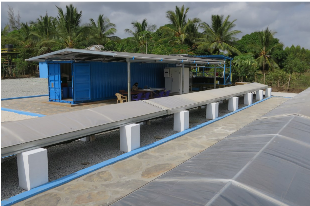
Abb. 4: Fertig gestelltes SolCoolDry – System: im Vordergrund die beiden solaren Tunneltrockner und im Hintergrund der Container mit der Batterie- und Solartechnik, welcher vom Solardach verschattet wird. Im Schatten auf der rechten Seite befindet sich der Eislagerraum.
