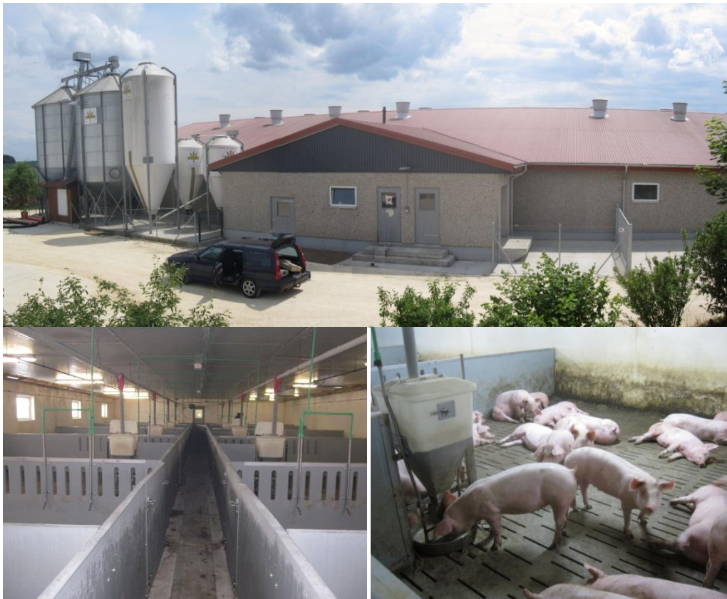
Abb. 23: (oben) Stall des Praxisbetriebs C (Hochdruckbefeuchtung) (unten links) Abteil mit an der linken und rechten Wand entlanglaufenden Hochdruckbefeuchtungsleitungen + Düsen (unten rechts) Bucht für 36 Tiere mit Breifutterautomat
