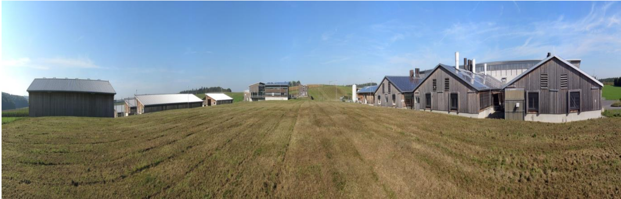
Abb. 10: Anlage der LSZ – Boxberg, rechts im Bild der wärmege­dämmte Mastschweine­stall
