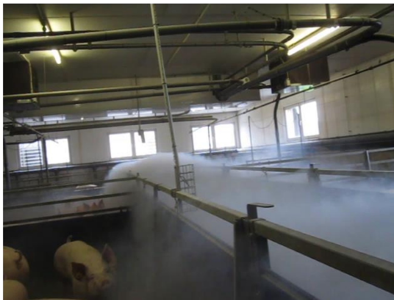
Abb. 18: Luftpfeile im Winter in Abteil C3 (Unterflurzuluft)
