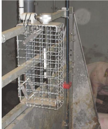
Abb. 26 Messsensoren im Schutzkäfig
