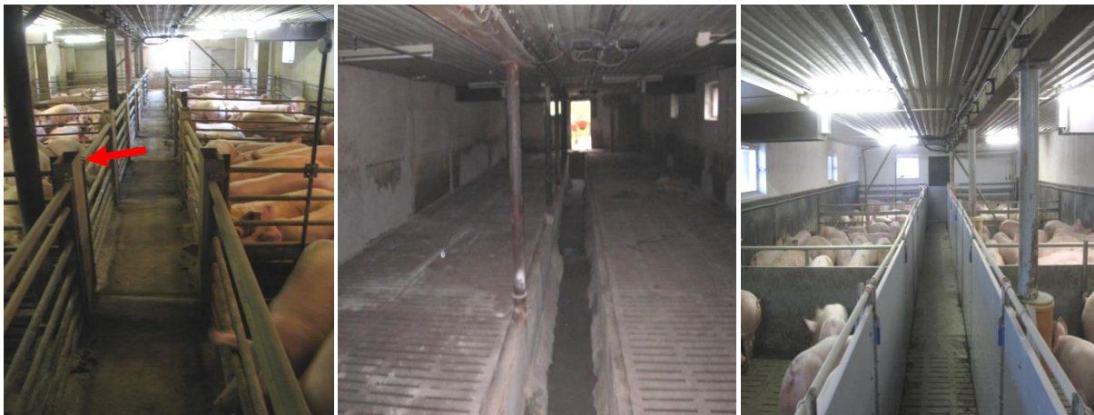
Abb. 21: (links) Abteil mit Unterflurzuluft über Röhren ins Abteil (roter Pfeil) (Mitte) Umbau, Entfernen des geschlossenen Zentralgangbodens (rechts) Unterflurzuluft durch Zentralgang mit Spaltenboden
