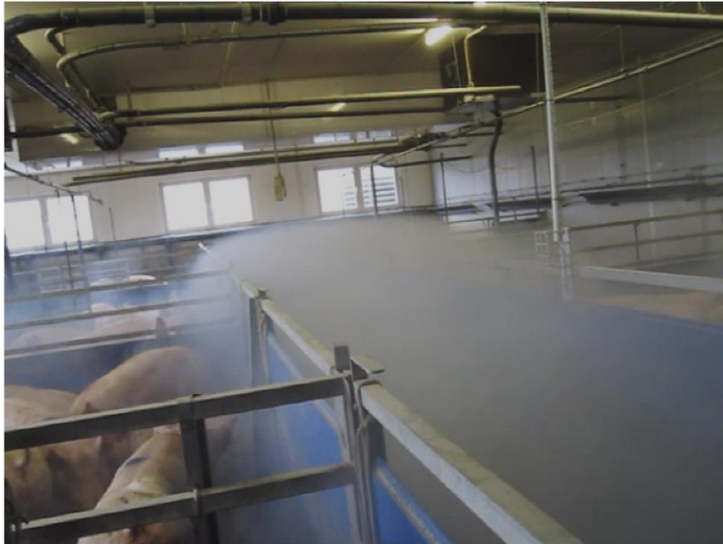
Abb. 92: Nebelprobe im Unterflurzuluftabteil, Wintersituation
