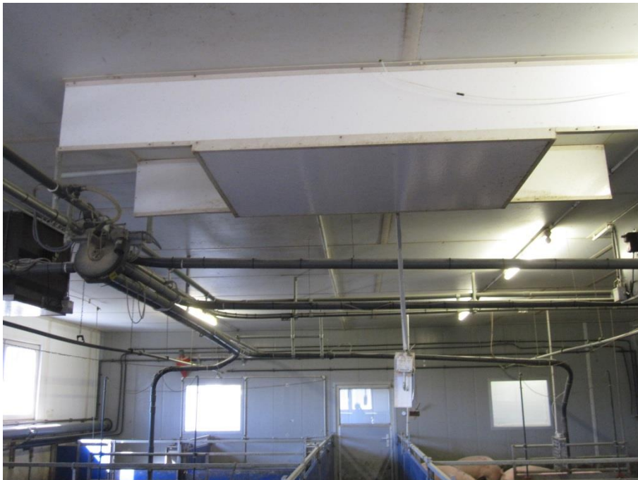
Abb. 15: Abluftkasten zur Verhinderung eines Lüftungskurzschlusses bei der Unterflurzuluft
