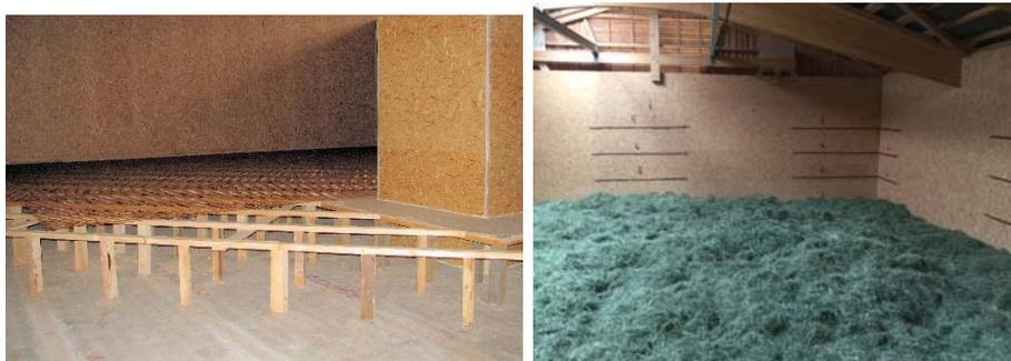
Abb. 5: Beispiele für den Aufbau einer Boxentrocknung: Unterbau, Rost, Seitenabdeckung und Höhenmarkierung (links, Wirleitner, 2016) und Höhenmarkierung an den Seitenwänden (rechts, KTBL)
