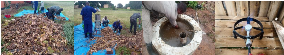
Biogasproduktion: Jackfruchtreste werden gesammelt; zerkleinert; der Biovergärungsanlage zugefügt; Biogas aus den Pflanzenresten (Uganda) © Denis Nsubuga
