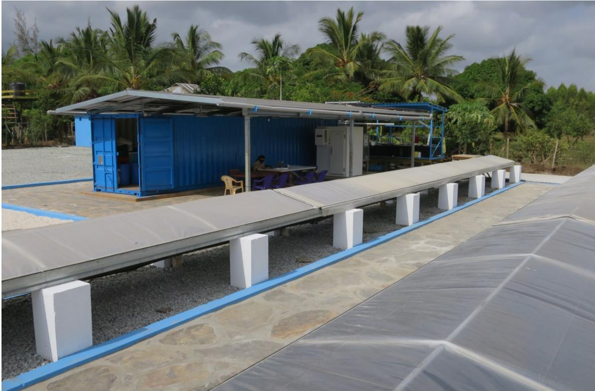
Abb. 4: Fertig gestelltes SolCoolDry – System: im Vordergrund die beiden solaren Tunneltrocker und im Hintergrund der Container mit der Batterie- und Solartechnik, welcher vom Solar-
