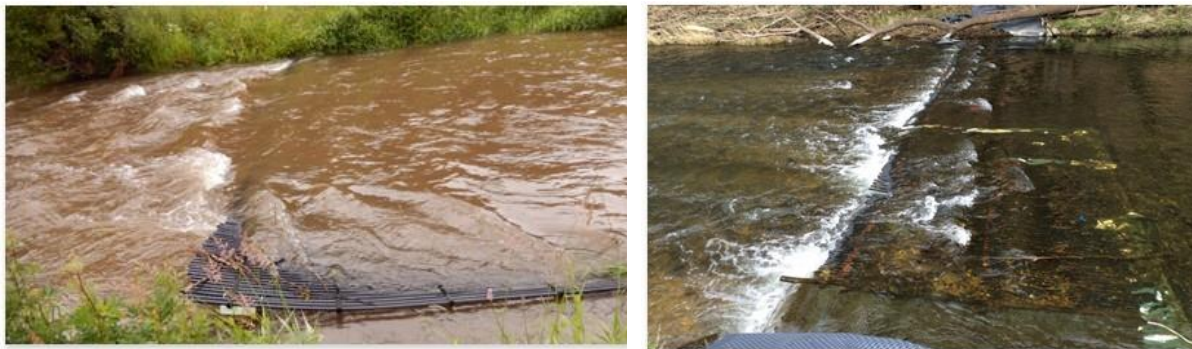
Abbildung 5: Dynamische Fischwehre am oberen Ende der Referenzstrecke während und nach einem Hochwasserereignis
