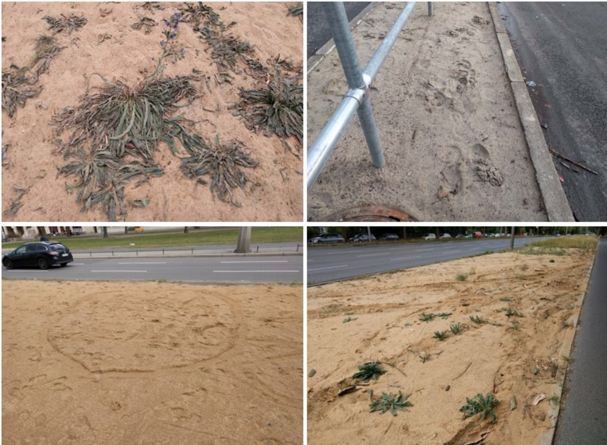
Abb. 40: Störeinflüsse auf den Versuchsflächen. Von links oben nach rechts unten: Niedergedrückte Pflanzen ( Echium vulgare ) nach Berliner Bierfestival (Frankfurter Allee, 30.08.2018); hohe Trittbelastung bereits kurz nach Versuchsbeginn (Steglitzer Damm, 10.01.2019); Botschaft im Sand (Frankfurter Allee, 05.04.2018); Fahrzeugspuren (Heerstraße, 05.07.2018)
